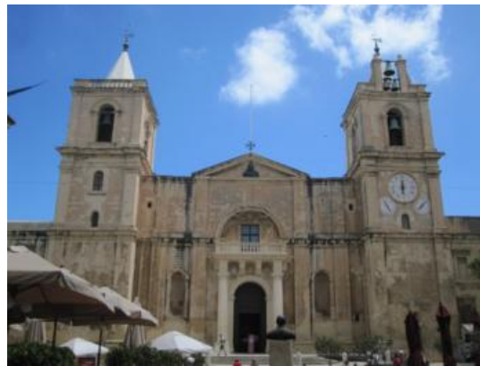
Fachada principal de la Concatedral de San Juan
