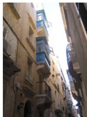
Fachada del apartamento
