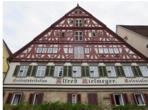
Fachada de entramado de madera Esslingen am Neckar
