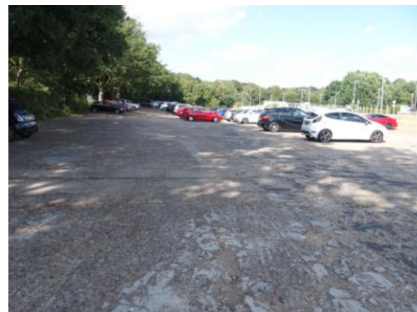
Vista del antiguo circuito-aparcamiento. La calzada es la original y está muy estropeada.
