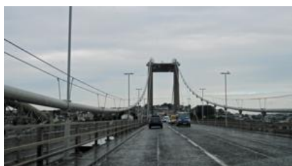
El Tamar Bridge
