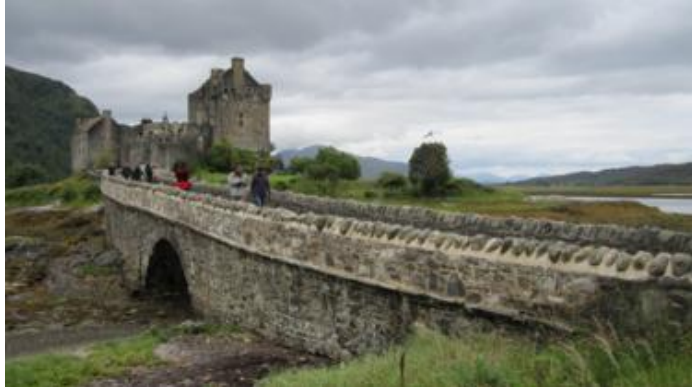
Eilean Donan. El puente de acceso.
