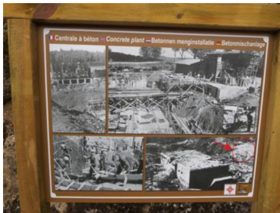
Imágenes de la construcción del búnker.
