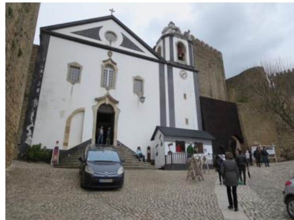
La iglesia está adosada a la muralla del castillo
